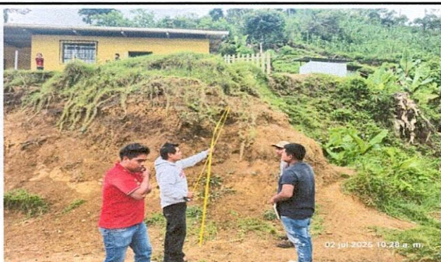
Foto 3: Área de enfrente inicio de medicion acordado en los renglones a construir
