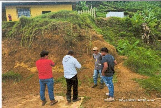
Foto 1: Área derecha del espacio en donde se iniciara con zanqueo para la construcción del muro de contención
